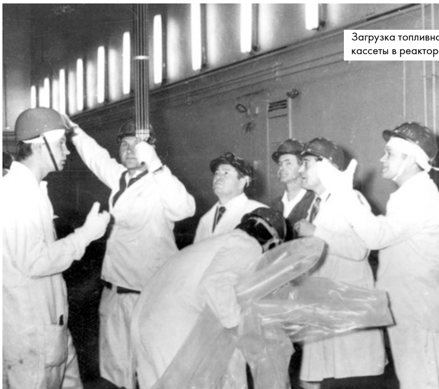
Перед физическим пуском энергоблока N I
