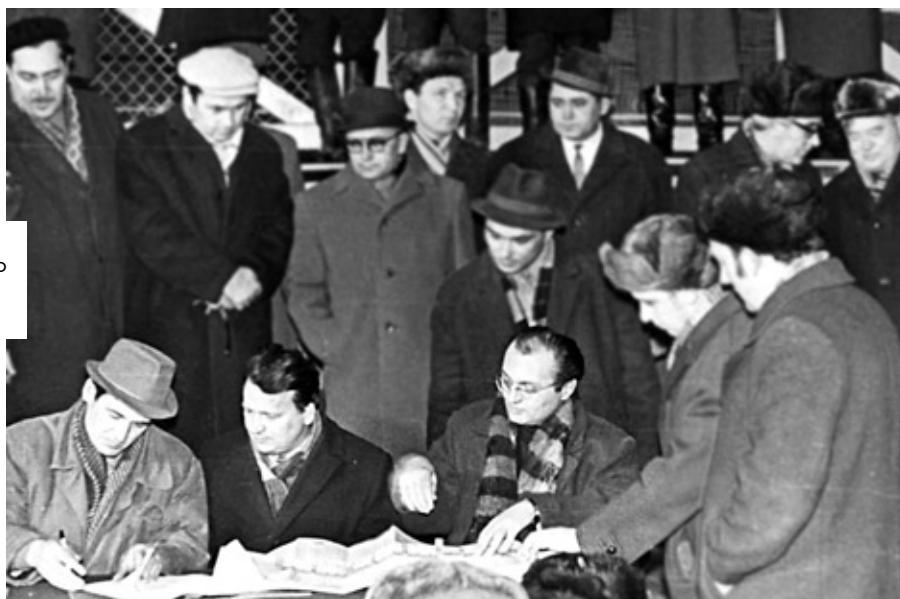
Подписание акта сдачи фундамента для второго турбогенератора. Март 1971 г.
