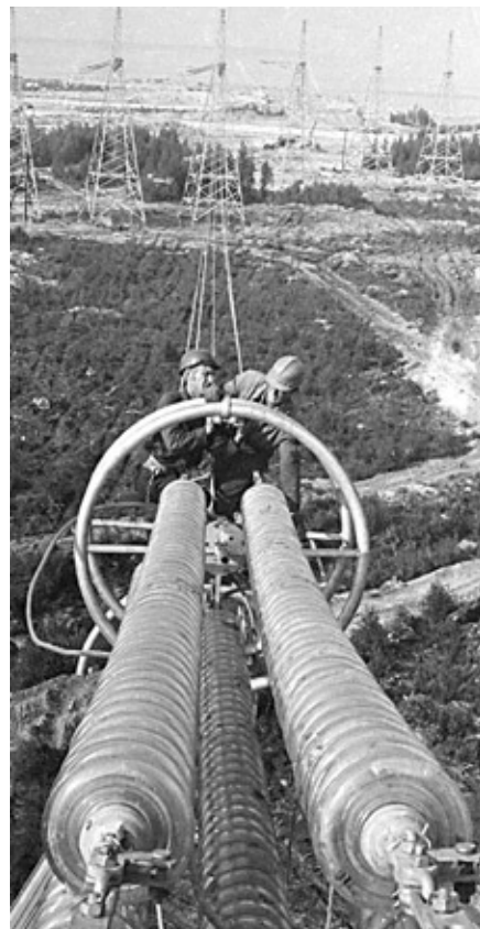
Монтаж пролетов ОРУ-750 кВ
